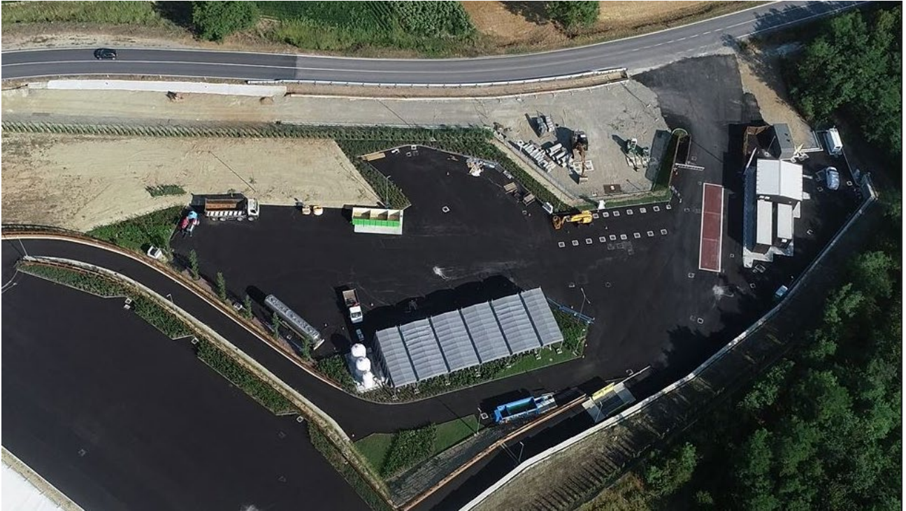
Figura 16: Vista aerea dell'area di ingresso (piazzale, box uffici, Pesa, ecc.) del sito di discarica di Sezzadio
